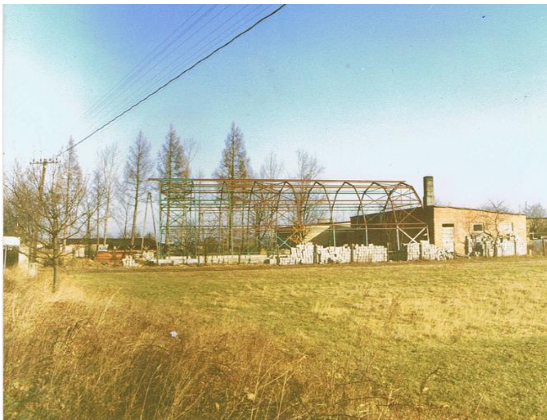
Sala gimnastyczna w trakcie budowy- r. szk. 1991/1992
